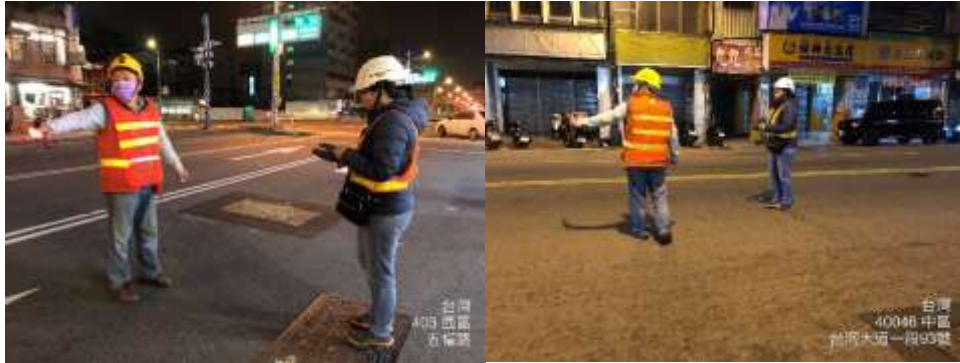
圖3、道路照明普查作業現場畫面
